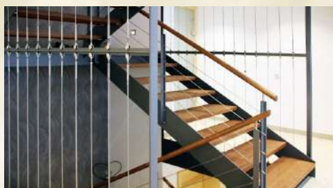
Marches d'escalier en chêne A/B intégrées dans des limons métalliques
