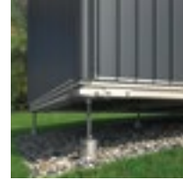
Compensation de la hauteur avec des vis de fondation
