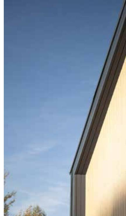
**R3D 00 1n hf + R3D 00 3n hf** Pin du Nord thermo, 27 et 44 x 120 mm
