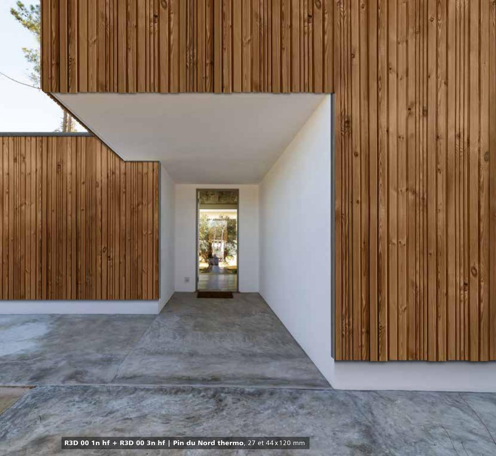
**R3D 00 1n hf + R3D 00 3n hf | Pin du Nord thermo, 27 et 44x120 mm**
