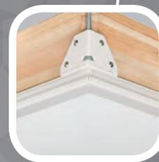
Les bordures de finition intégrées au cadre métallique garantissent un fini esthétique entre le plafond et l'escalier installé.
