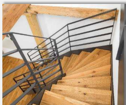
Marches en chêne rustique encastrées dans des limons métalliques
