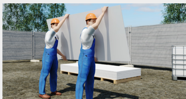
Les panneaux doivent toujours être manipulés sur les chants, afin d'éviter tout risque de déformation.
